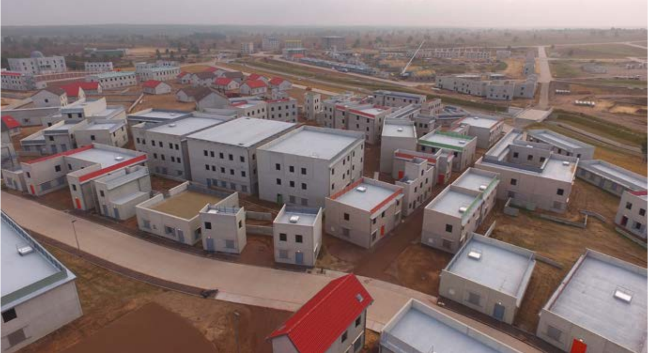
Abbildung 39: Urbaner Ballungsraum „Schnöggersburg“
