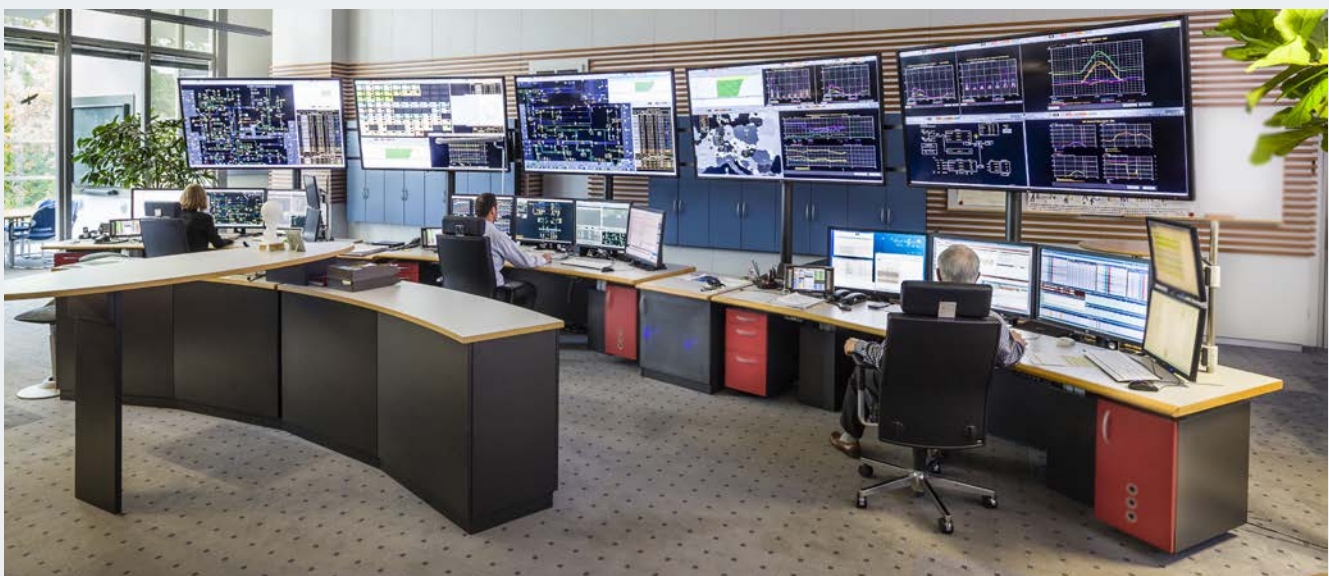
Schichtingenieure führen das Höchstspannungsnetz in der TenneT-Regelzone: Oberstes Ziel ist dabei, die Kenngrößen Strom, Spannung und Netzfrequenz jederzeit in den zulässigen Grenzen zu halten.
