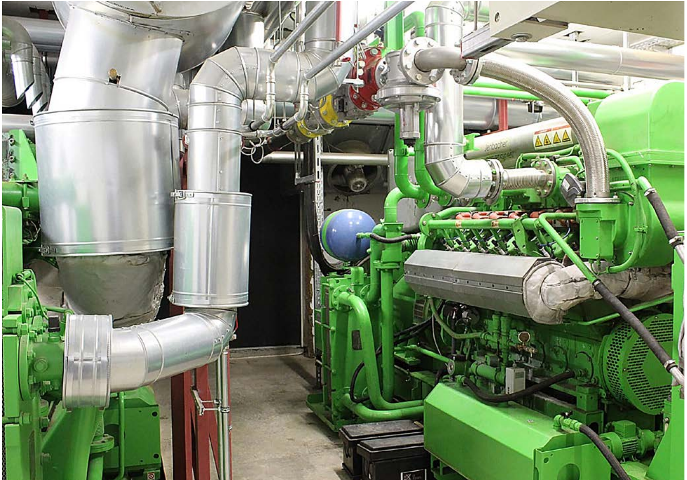
Biogasanlage Zellerfeld: Wichtig für die Kombination von PV-Anlagen und Biogasanlagen auf Verteilnetzebene ist die Leistungsfähigkeit der Blockheizkraftwerke im flexiblen Betrieb für Wärme- und Stromerzeugung.
