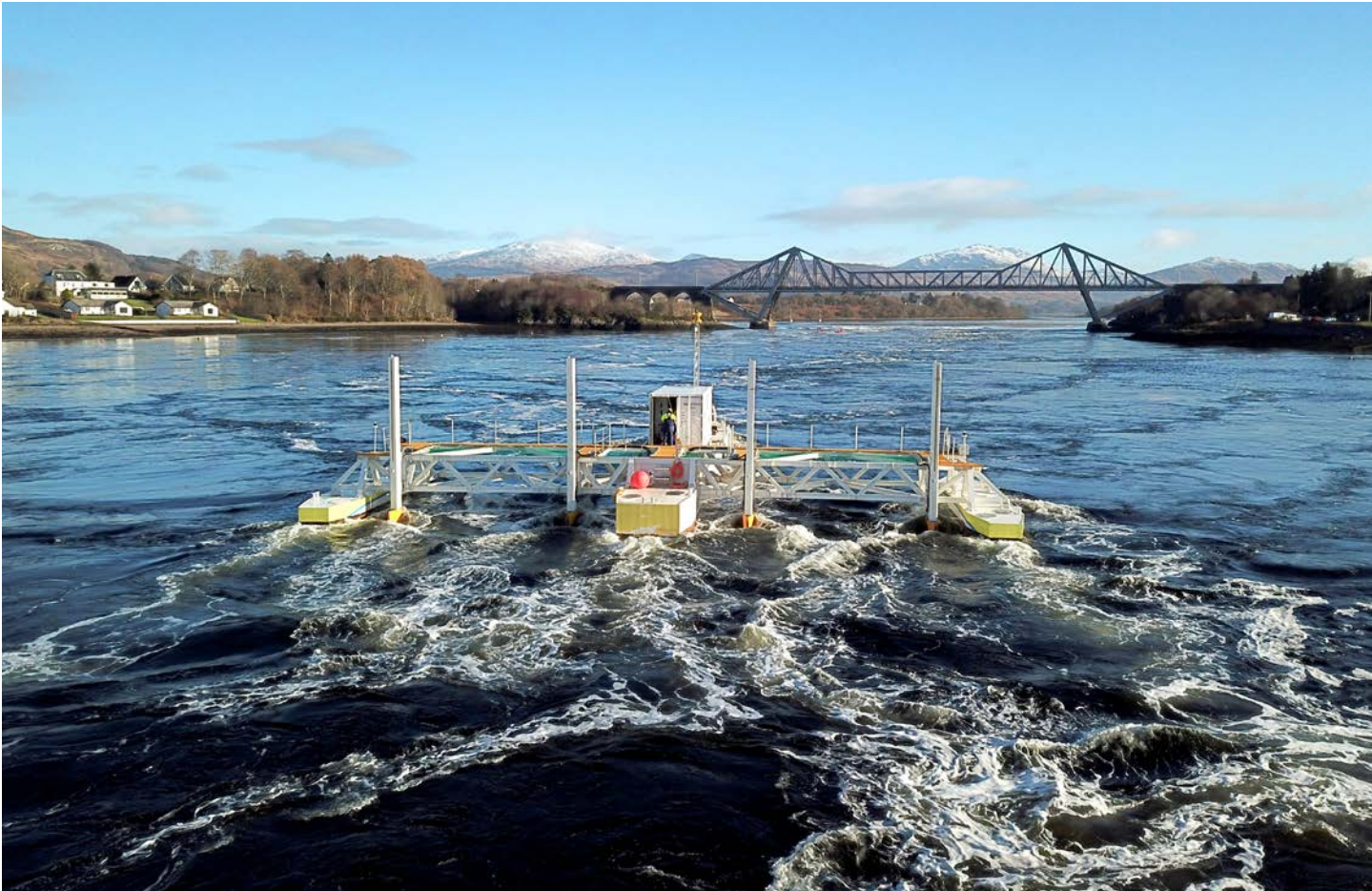
Im Gezeitenkraftwerk Tidal Power ist ein modulares Unter-Wasser-Turbinensystem an einer schwimmenden Plattform befestigt.
