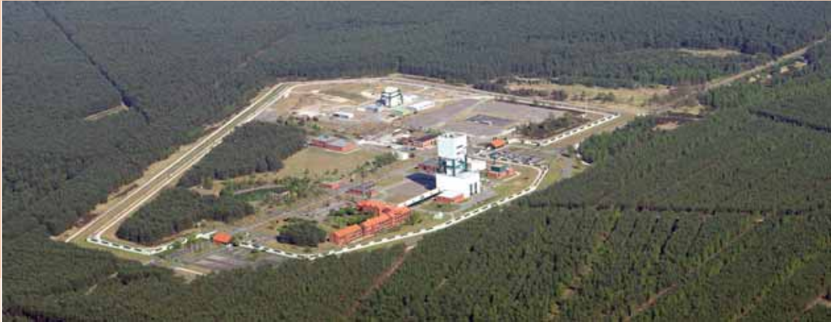
Abb. 2: Luftbild des Standortes Gorleben
