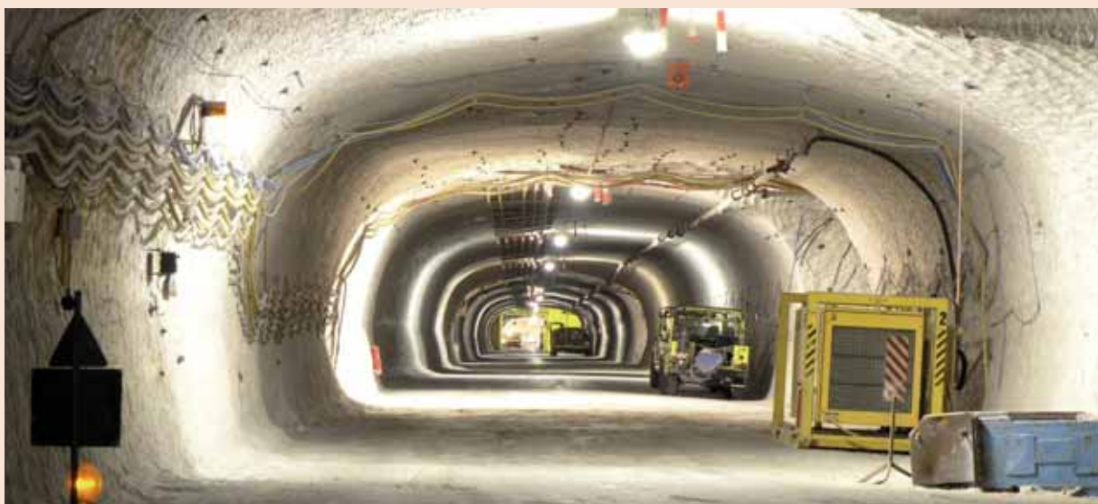
Abb. 10: Blick in die Hauptförderstrecke auf der 840m-Sohle
