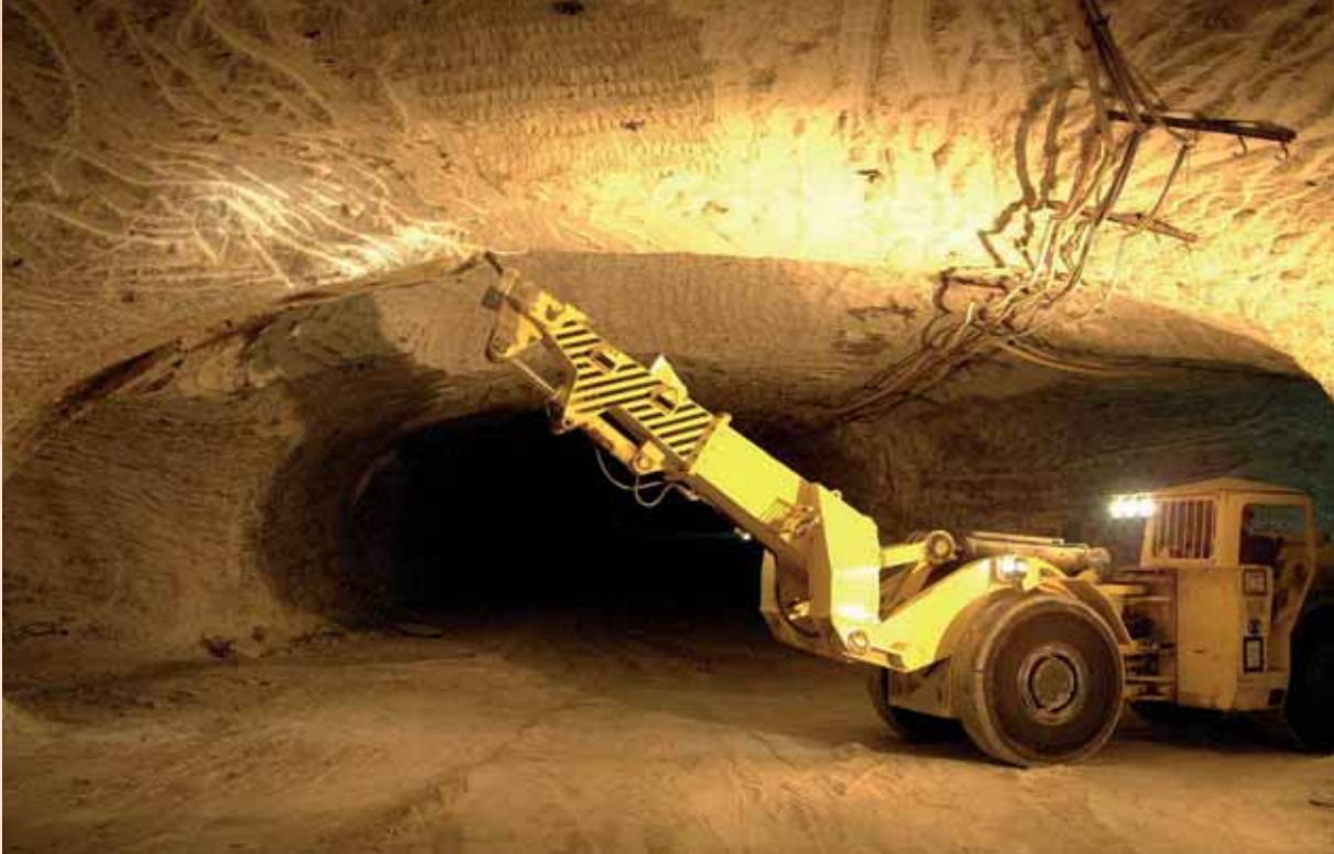
Abb. 13: Beräumungsarbeiten in einer Strecke der 840m-Sohle
